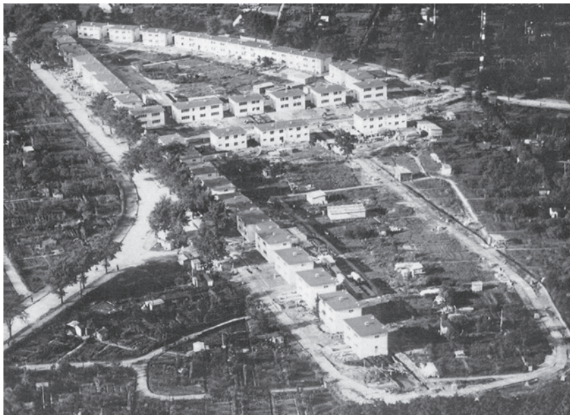
Neu-Lokstedt 1931: Karl- und Bachstraße (heute Julius-Vosseler- Straße/Vizelinstraße), Architektur im Bauhaus-Stil
