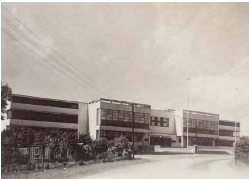
Die Schule nach der Fertigstellung. Später mussten wegen der Flughafen-Sicherheit Anfang der 1960er Jahre mehrere Stockwerke abgerissen werden
