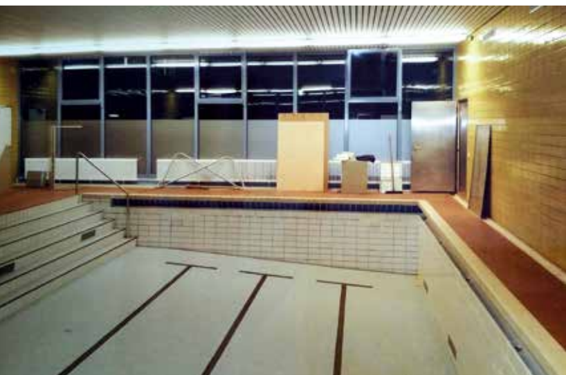
Am Ende hatte der Verein gewonnen: Das Lehrschwimmbecken während der Renovierungsphase
