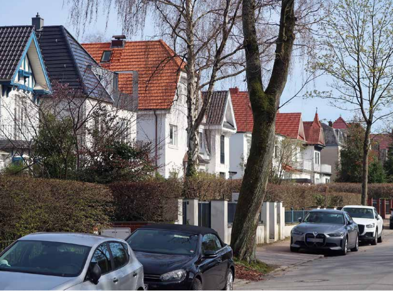
Insgesamt macht die Aneinanderreihung der Stadtvillen im Brunsberg einen recht harmonischen Eindruck. Nur an wenigen Stellen wird der Gesamteindruck durch Bausünden auseinandergerissen.
