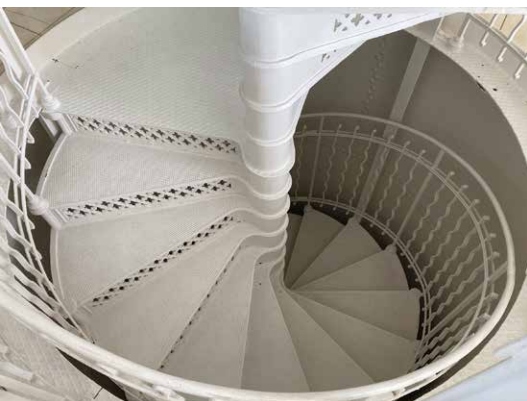
Die Wendeltreppe im Zentrum des Turms ist im Original erhalten und führt hoch bis in die Kanzel am oberen Umlauf.
