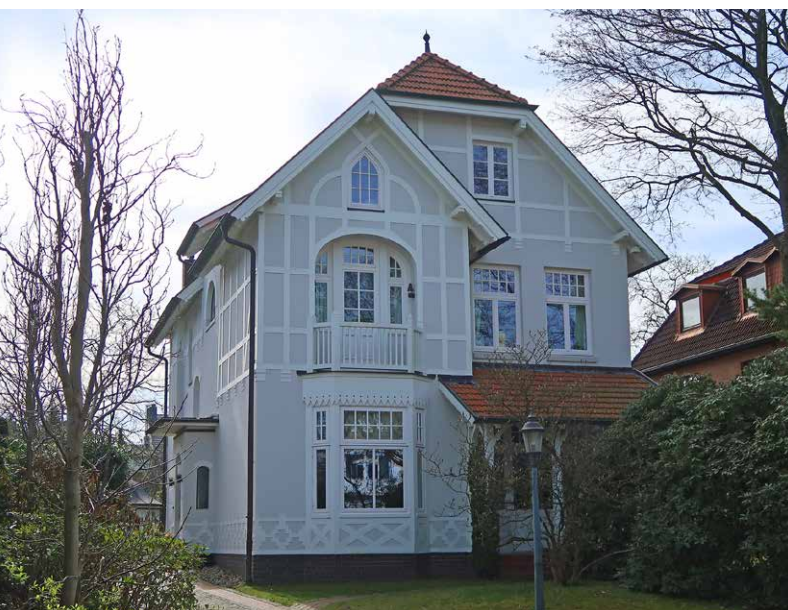
Auch diese große Stadtvilla im Brunsberg hat eine Vielzahl von Fachwerkelementen in der Fassade – wobei es sich in vielen Fällen nicht um echtes Fachwerk (in der Mauer verankertem hölzernem Gefache), sondern um aufgesetzten Schmuck handeln dürfte.
