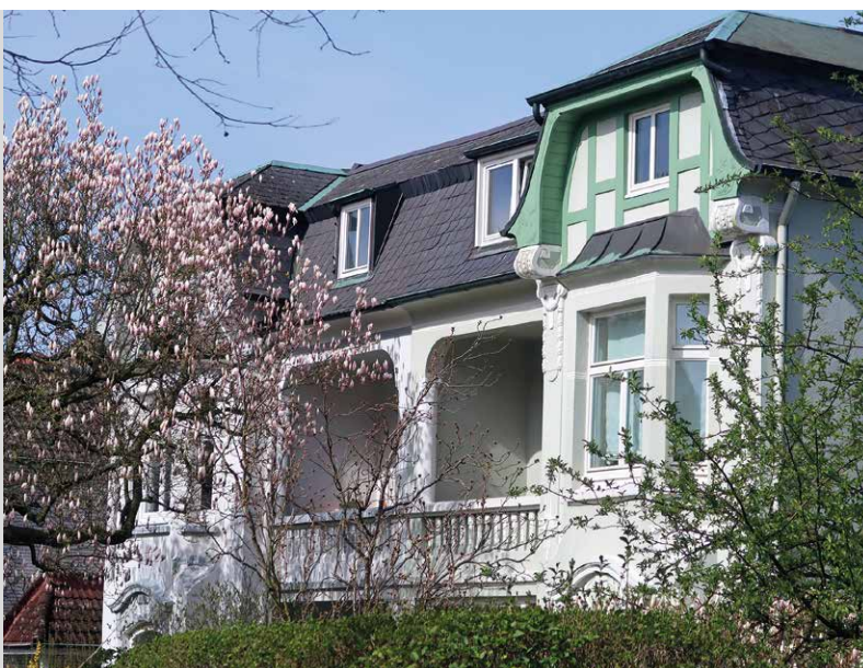
Hier ein besonders schönes Beispiel von Doppelhaus-Konstruktionen der „Beamten-Häuser“ im Behrkampsweg 9-11. Die meisten Häuser wurden jedoch zwischenzeitlich baulich so stark verändert, dass der ursprüngliche Zustand kaum noch zu erahnen ist.
