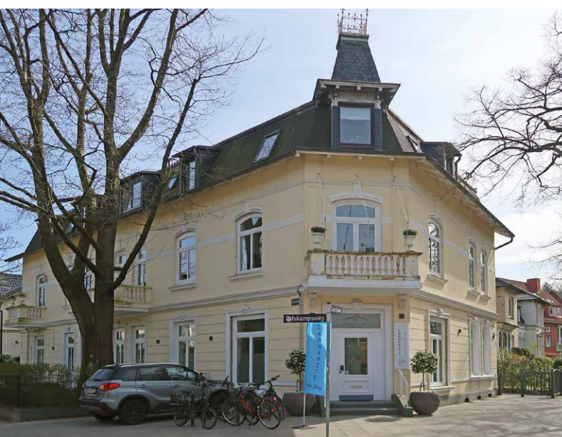
An der Ecke Behrkampsweg und Grandweg fällt dieses große Eckhaus ins Auge. Obwohl die Fassade, mit ihren Stuckelementen und Balkons einen schönen originalgetreuen Eindruck macht, stehen die Dachgauben in lieblosem Kontrast.
