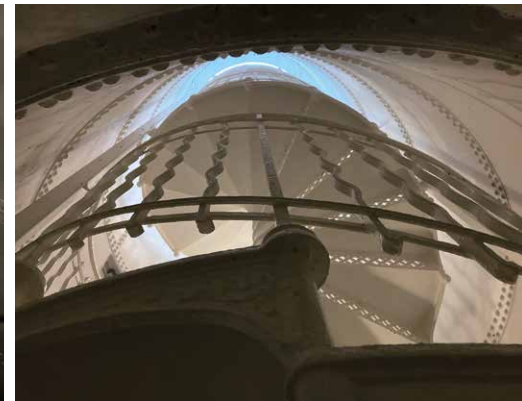
Die zentrale Wendeltreppe führt durch den ehemaligen Wassertank nach oben zum Wohnbereich.
