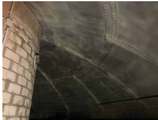
Angekommen unterhalb des genieteten Wassertanks, der heute nicht mehr genutzt wird, jedoch der Statik für den darüber befindlichen Wohnbereich dient.
