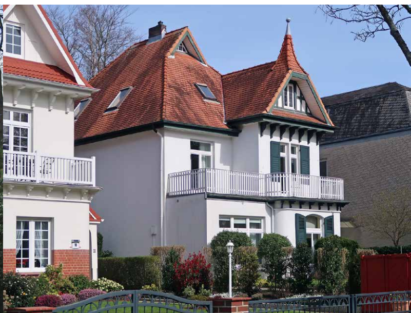
Das Haus Brunsberg 16 (rechts) sticht durch seine vielseitige Spitzgiebel-Konstruktion hervor. Der linke Teil des Gebäudes wirkt allerdings nachträglich baulich vereinfacht. Davon zeugen auch die Dachfenster in der Schräge.
