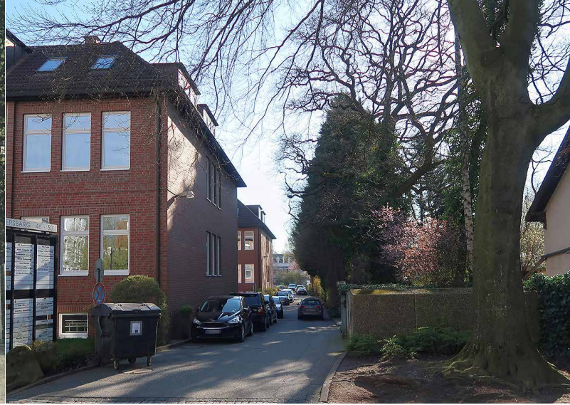
Heute sind an gleicher Stelle, in der Straße Rütersberg 46-50, zwei Bürogebäude, die in den 1990er Jahren entstanden, in denen eine Vielzahl kleiner und mittlerer Unternehmen unterschiedlicher Branchen zu günstigen Konditionen ein Büro unterhalten. Den überquellenden Briefkästen zufolge, auch allerlei Leerstände.
