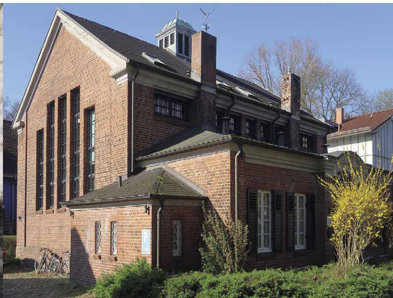
Der attraktive Rotklinkerbau in der Straße „Bei der Pulvermühle“ wurde in den 1990er Jahren liebevoll restauriert und wird heute von einer Handvoll kleiner Unternehmen genutzt; einige Jahre zuvor von einer Hochzeitsagentur.
