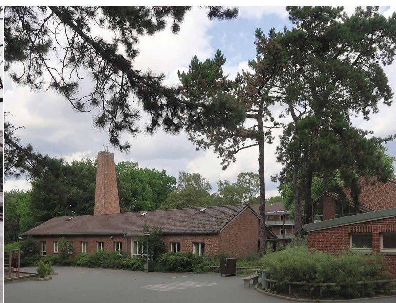
Die Schule hat sich in den vergangenen 63 Jahren baulich fast nicht verändert; nur die Bäume sind mächtiger geworden. Teile des Ensembles stehen auf der Denkmalliste. Die Schulgebäude werden heute als vierzügige Grundschule genutzt. Foto August 2019
