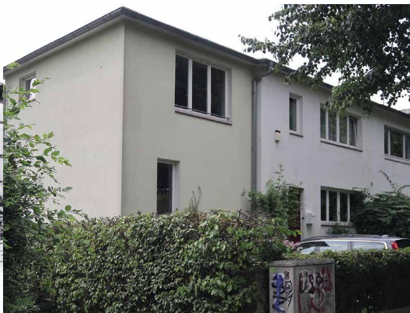
Die Hausbesitzer waren stolz auf ihre modernen Heime, obwohl das Quartier von den Alt-Lokstedtern despektierlich „Pappiedlung“ genannt wurde. Heute befinden sich fast keine Häuser mehr im ursprünglichen Zustand. Hier ein relativ originales Haus an der Ecke Beethovenallee / Vizelinstraße
