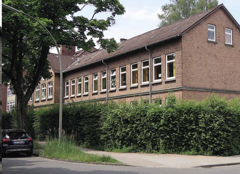
Ab den 1950er Jahren wurde die Schule durch einen Mittelflügel ergänzt. Später wurde die große Turnhalle gebaut und der Altflügel komplett entkernt und saniert. Später kam noch ein Aulafügel hinzu und 1975 das heutige Grundschulgebäude
