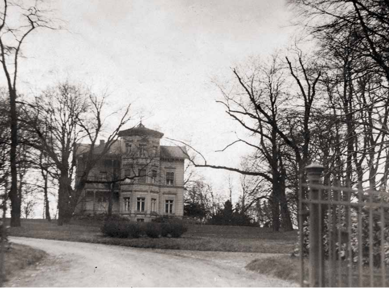
Diese wunderschöne von Martin Haller entworfene Villa, ließ der Kaufmann Carl Heinrich Willink in dem „Lustgarten am Rütersberge“ 1861 erbauen. Bis 1920 wurde sie als Sommersitz der Familie genutzt, Anfang der 1980er Jahre dann abgerissen. Foto um 1910
