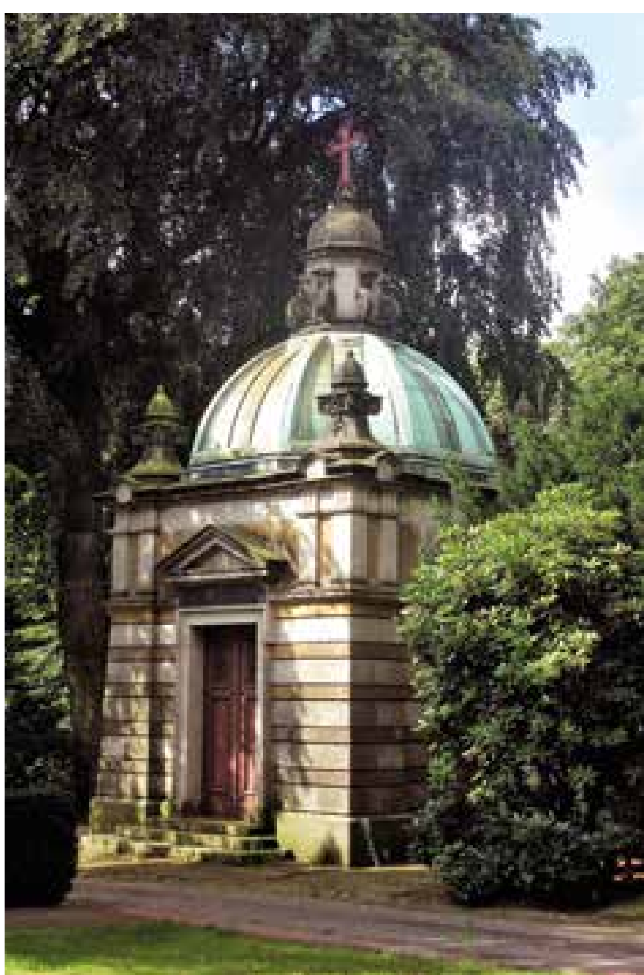
Das Heymann Mausoleum ist das einzige Gebäude dieser Art auf dem Friedhof. Es wurde aus Buntsandstein im Stil des Historismus erbaut, die Bauzeit betrug etwa ein Jahr. Auf der schwarzen Marmortafel über der Eingangstür finden wir einen Vers aus der fünften Strophe eines sehr alten Kirchenliedes. Über allem wölbt sich ein imposantes Kupferdach mit einer bekrönenden Laterne, auf der ein großes Kreuz steht.
