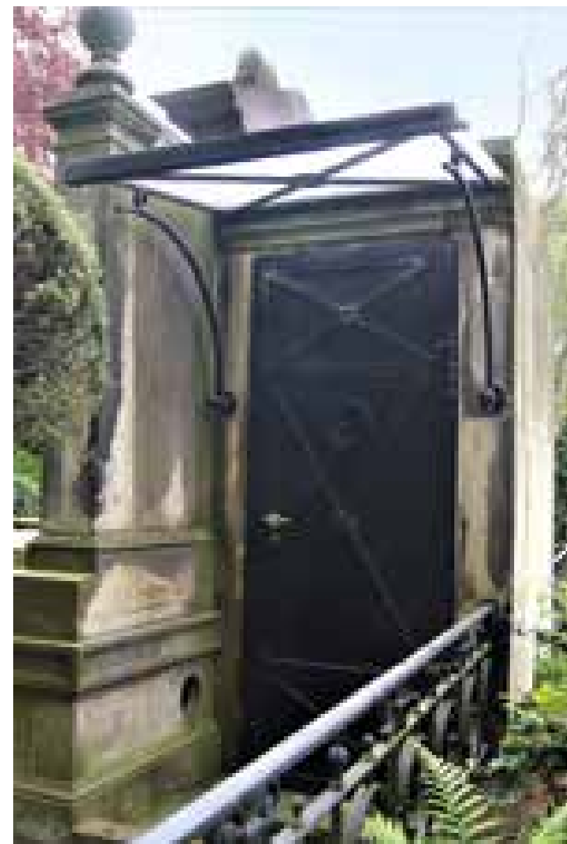
Die Gruftabdeckung ist abnehmbar (linkes Foto: Sammlung Johanna Brede), um weitere Beisetzungen vornehmen zu können. Bei den größeren Gräften befindet sich auf der Rückseite des Grabmals ein Eingang zur Begehung der Gruft (rechtes Bild).
