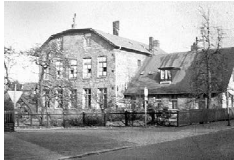
Die „alte“ Schule am Schulweg – von der heutigen Vogt-Wells-Straße aus gesehen
