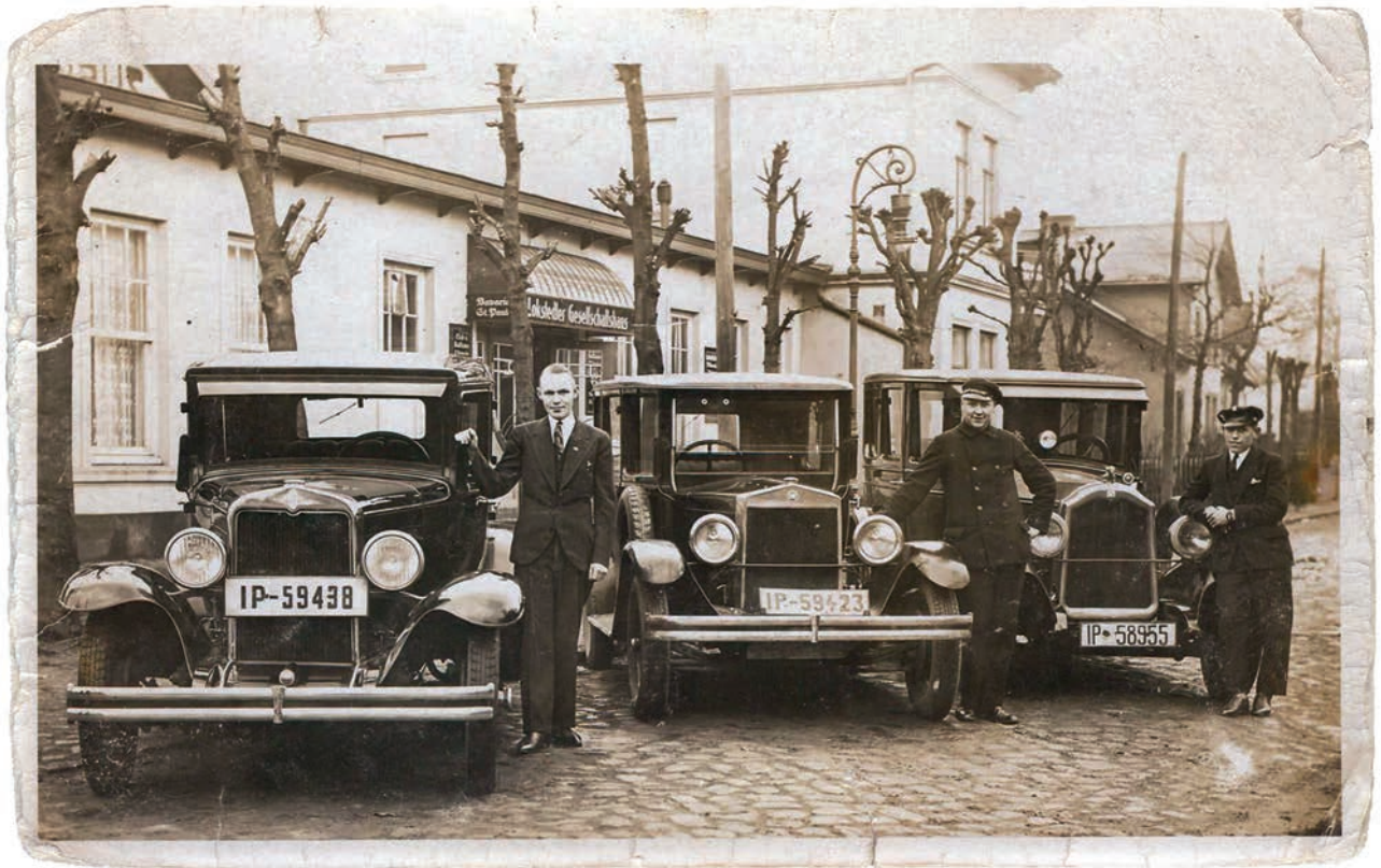
Lokstedter Gesellschaftshaus am Rüttersberg, 1930
