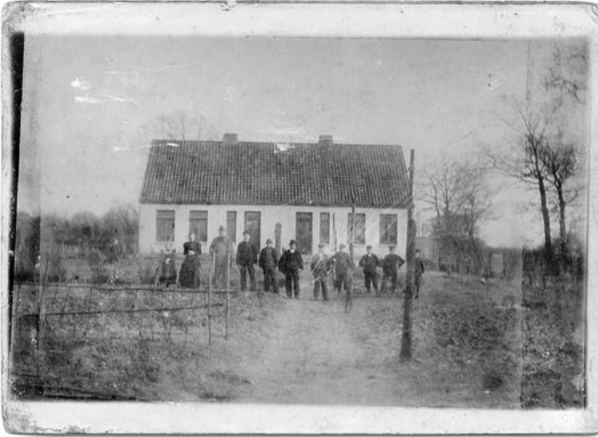
Die Nordseite des Hauses Hinter der Lieth 44, um 1900
