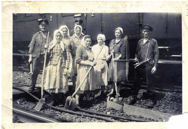
Ukrainische Zwangsarbeiter bei der Ausbesserung zerstörter Gleise für die Reichsbahn an der Bahnlinie Hamburg-Berlin, um 1944. Foto: KZ-Gedenkstätte Neuengamme
