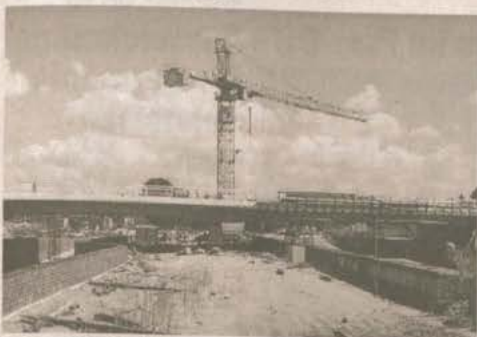
Die neue Brücke überspannt den alten Krohnstiegtunnel (rechts) und die im Rohbau fertige neue Röhre (links).
